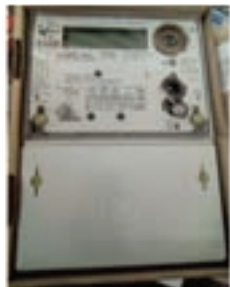
Slika 9: Dvosmerno, trofazno digitalno brojilo
