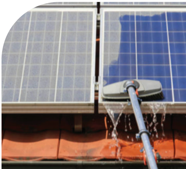
Slika 14: Čišćenje fotonaponskih panela
