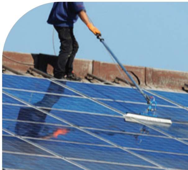
Slika 13: Čišćenje fotonaponskih panela
