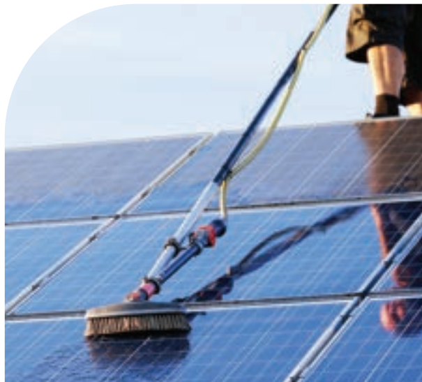
Slika 12: Čišćenje fotonaponskih panela
