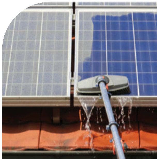
Slika 13: Čišćenje fotonaponskih panela
