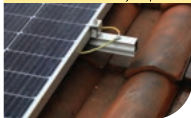
Slika 8: Noseća konstrukcija za panele
