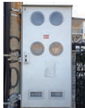
Slika 9: Dvosmerno, trofazno digitalno brojilo
