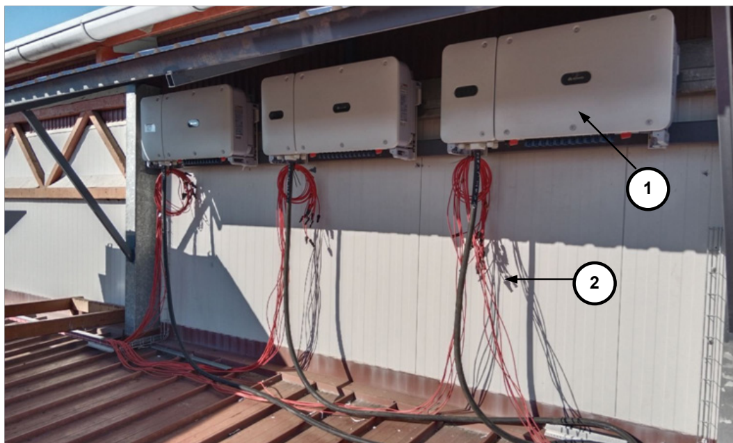
Slika 1.2 Izgled električne opreme u fazi postavljanja, montaže i povezivanja: 1-invertor, 2-provodnici i kablovi za povezivanje.
