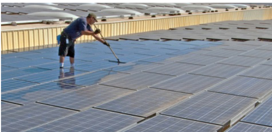
Slika 1.2 Tehničko lice pranjem površine uklanja nečistoće sa površine fotonaponskog panela..
