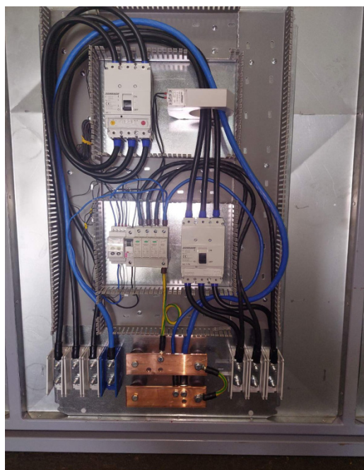
Slika 1.4 Izgled razvodnih ormara sa sklopnom i zaštitnom opremom fotonaponske elektrane.
