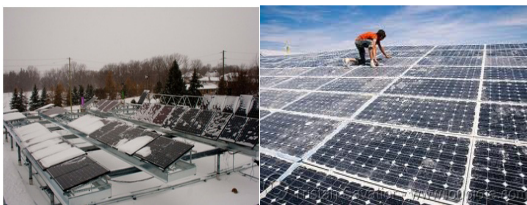
Slika 1.3 Redovno skidanje snežnog pokrivača sa fotonaponskih ploča.
