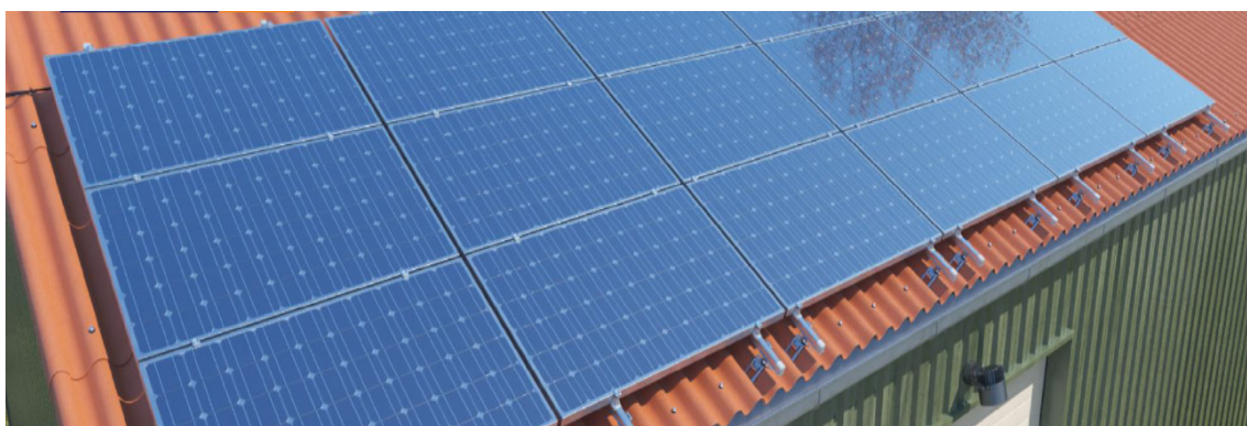
Slika 1.16 Prikaz mehaničkog nosača sa postavljenim fotonaponskim panelima na kosi valovit krov.
