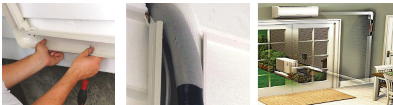
Slika 77: Postavljanje kanale za zaštitu cevovoda
