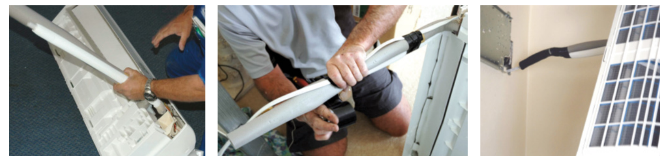
Slika 75: Instalacija unutrašnje jedinice
