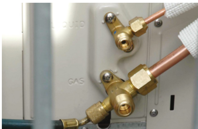
Slika 82: Test na nepropusnost
