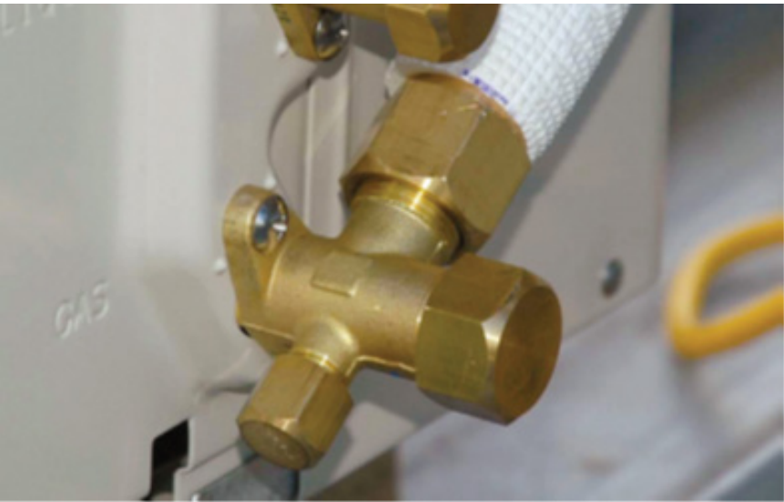
Slika 89: Zatvaranje poklopca na servisnim ventilima
