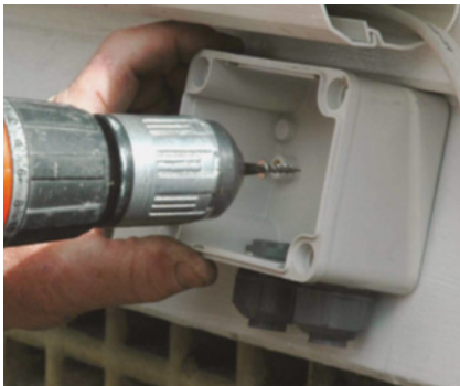
Slika 92: Priprema i povezivanje glavnog prekidača toplotne pumpe
