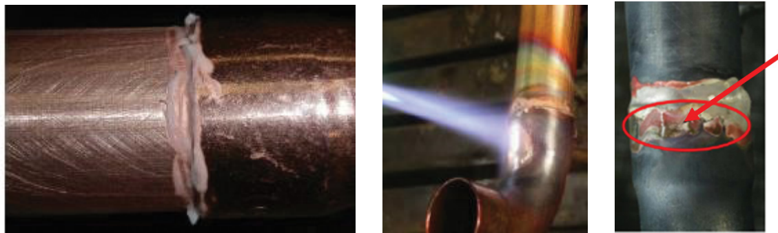
Slika 68: Nanošenje paste (fluksa) i zagrevanje spoja brenerom
