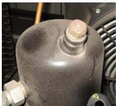
Slika 105: Curenje na sigurnosnim ventilima ili drugim odušnim elementima
