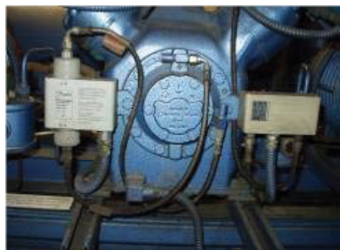
Slika 110: Curenje na sigurnosnim elementima sistema
