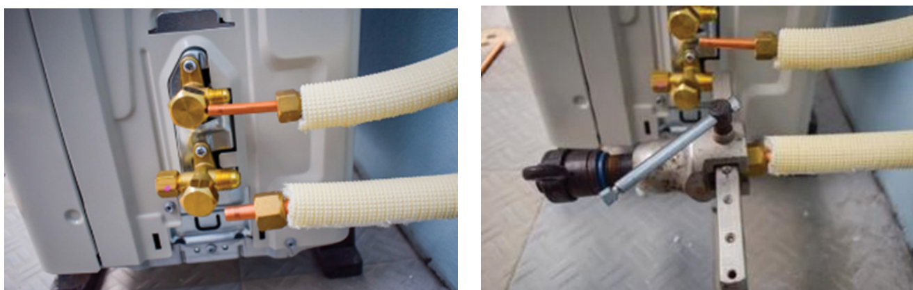
Slika 78: Povezivanje spoljašnje jedinice – priprema konusa (rastavljive veze)
