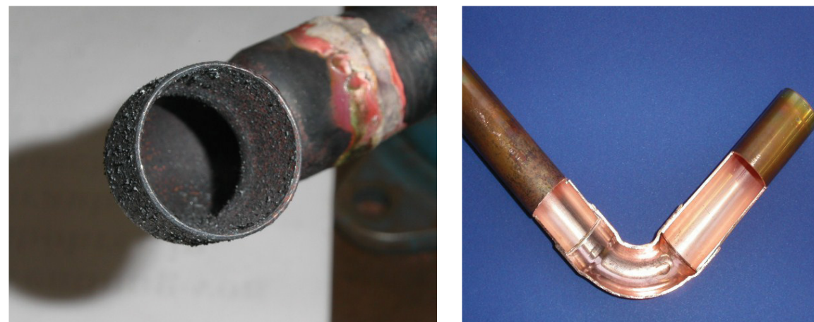
Slika 71: Pogled na cevi spojene tvrdim lemovima, bez i sa upotrebom azota tokom procesa
