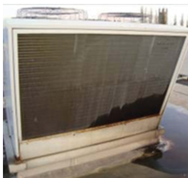
Слика 108: Цурење код кондензатора
