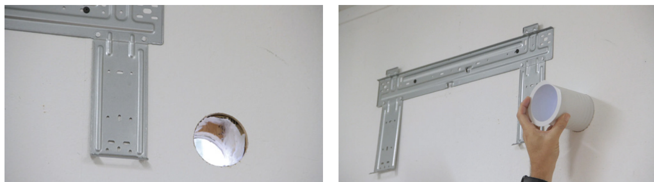
Slika 33: Postavljanje PVC cevi u izbušenom otvoru
