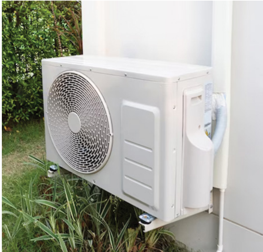
Slika 29: Instalacija spoljašnje jedinice na nosačima pričvršćeni za zid
