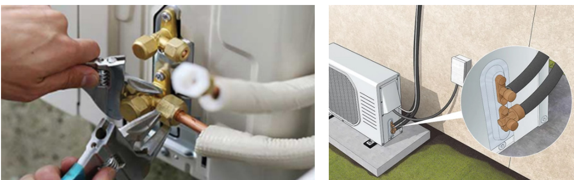
Slika 79: Povezivanje spoljašnje jedinice
